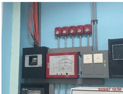
รูปที่ 59 ระบบตรวจสอบ ตรวจจับ และสัญญาณเตือนภัยกรณีเกิดเหตุฉุกเฉิน
